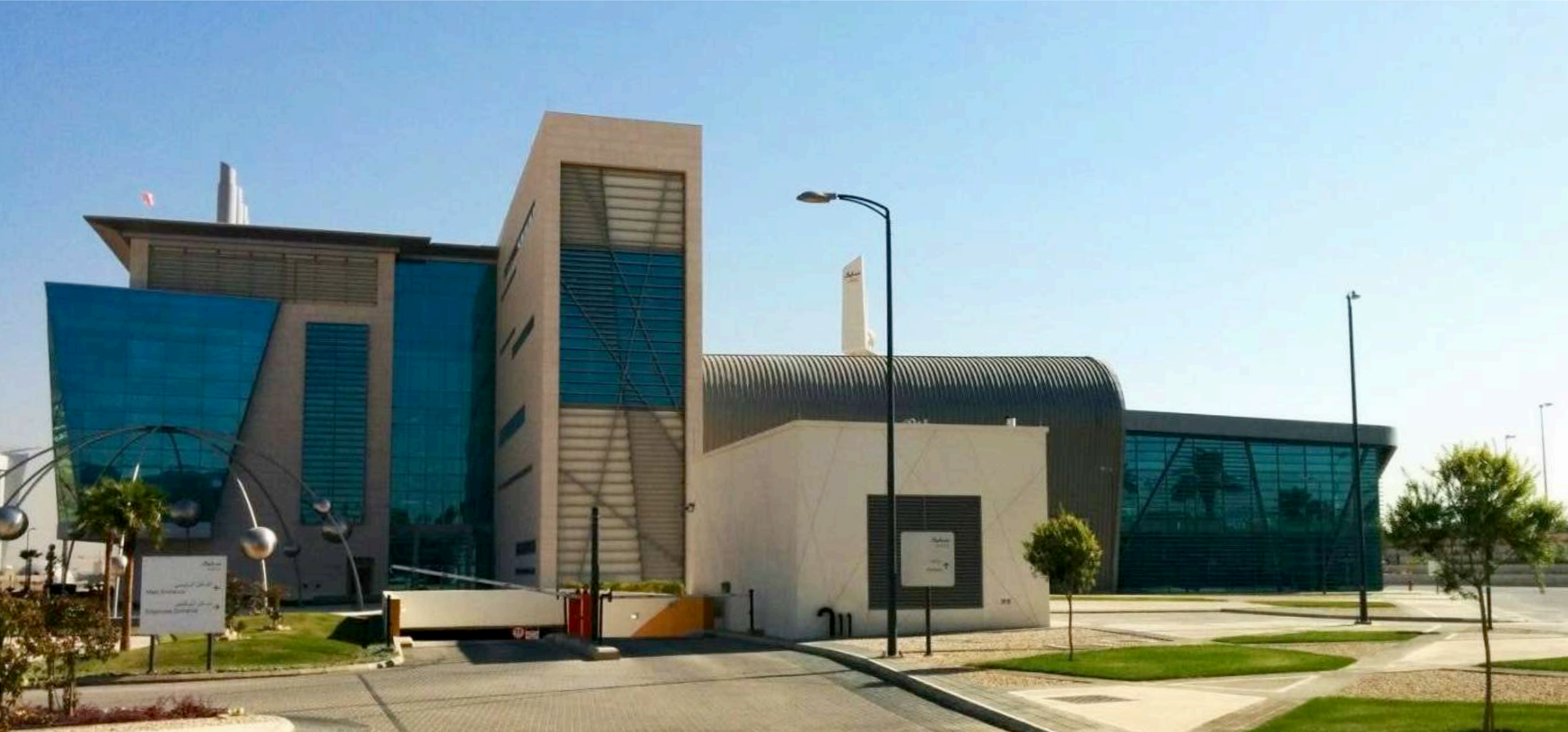
مبنى سابك لتطوير البلاستيك SABIC SPADC
